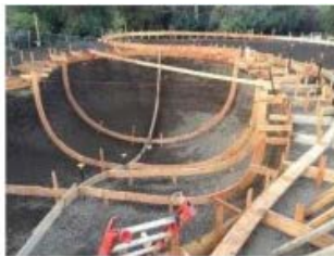
3 pav. Lenktos armatūros įrengimas.
