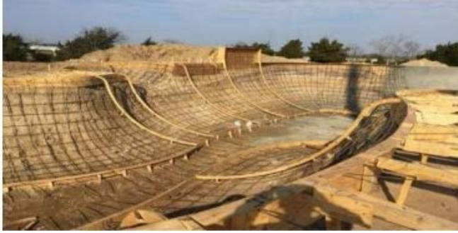
2 pav. Medinių klojinių montavimas.
